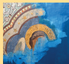
Un travail minutieux pour retirer 2 couches de peinture bleue
